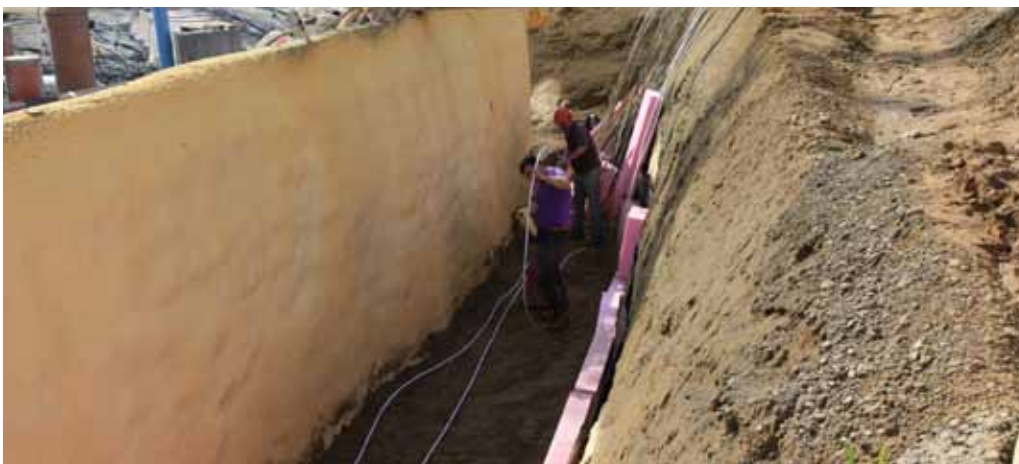
Bau vom Erdregister II
