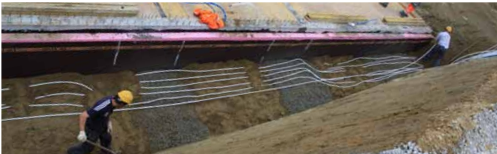
Bau vom Erdregister I
